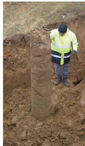
Colonne excavée à proximité des voies
