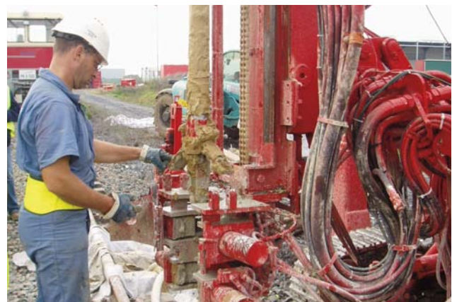
Atelier de forage sur plateforme ferroviaire
