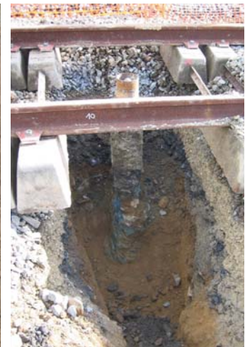
Colonne excavée sous les voies
