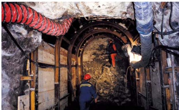
Excavation à l'abri de la voûte congelée.
