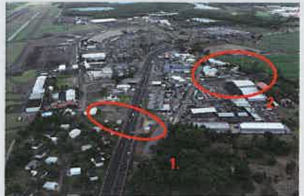
1. EMPLACEMENT DU FUTUR PONT 2. EMPLACEMENT DU FUTUR BÂTIMENT
